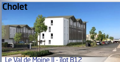
Le Val de Moine II - îlot B12 42 logements (24 T2 - 18 T3) Financement : 21 PLUS - 21 PLAI
