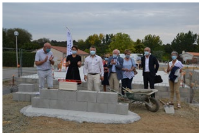
Nueil les Aubiers - Béthanie II 6 logements locatifs - 18 septembre
